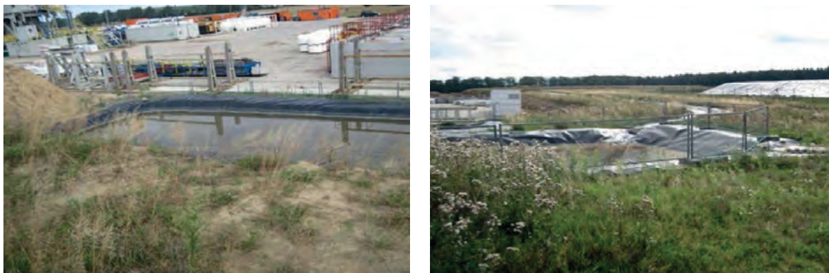
Rys. 2.5 Zbiorniki drenażowe w rejonie zakładu Lubocino
