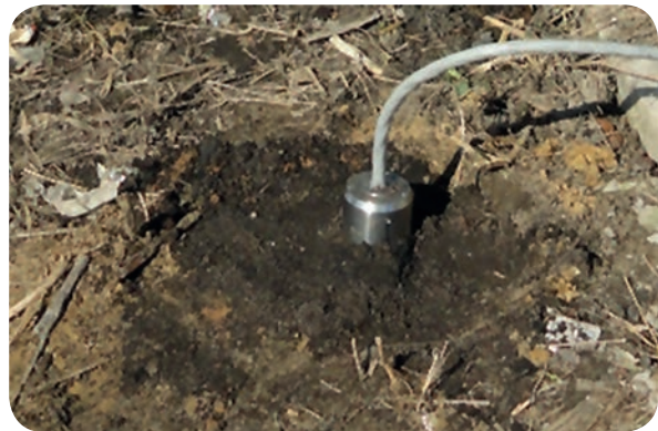
Rys. 2. Przykładowy sposób montażu czujnika geofonowego aparatury AMAX w gruncie
